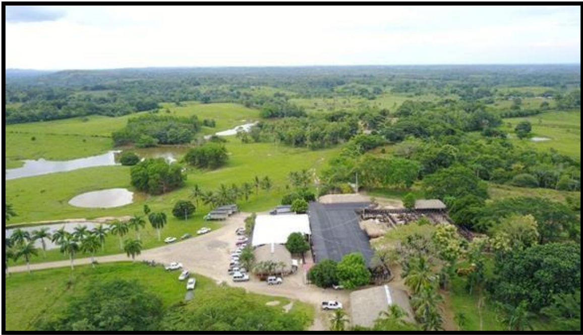
Figura 1. Vista aérea de las instalaciones de la Subasta Santa Clara, Sahagún, Córdoba. Fuente: Subasta Santa Clara
